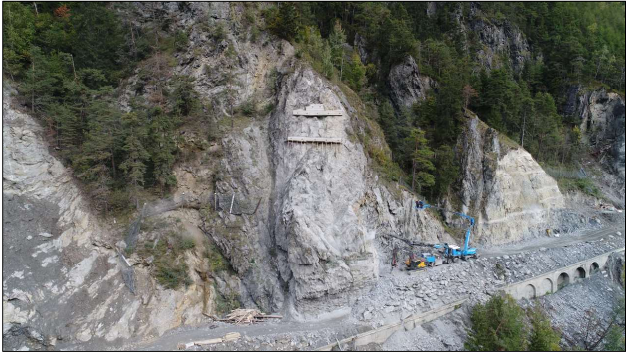
Abbildung 12: Kopfsicherung von Felsfeilern
