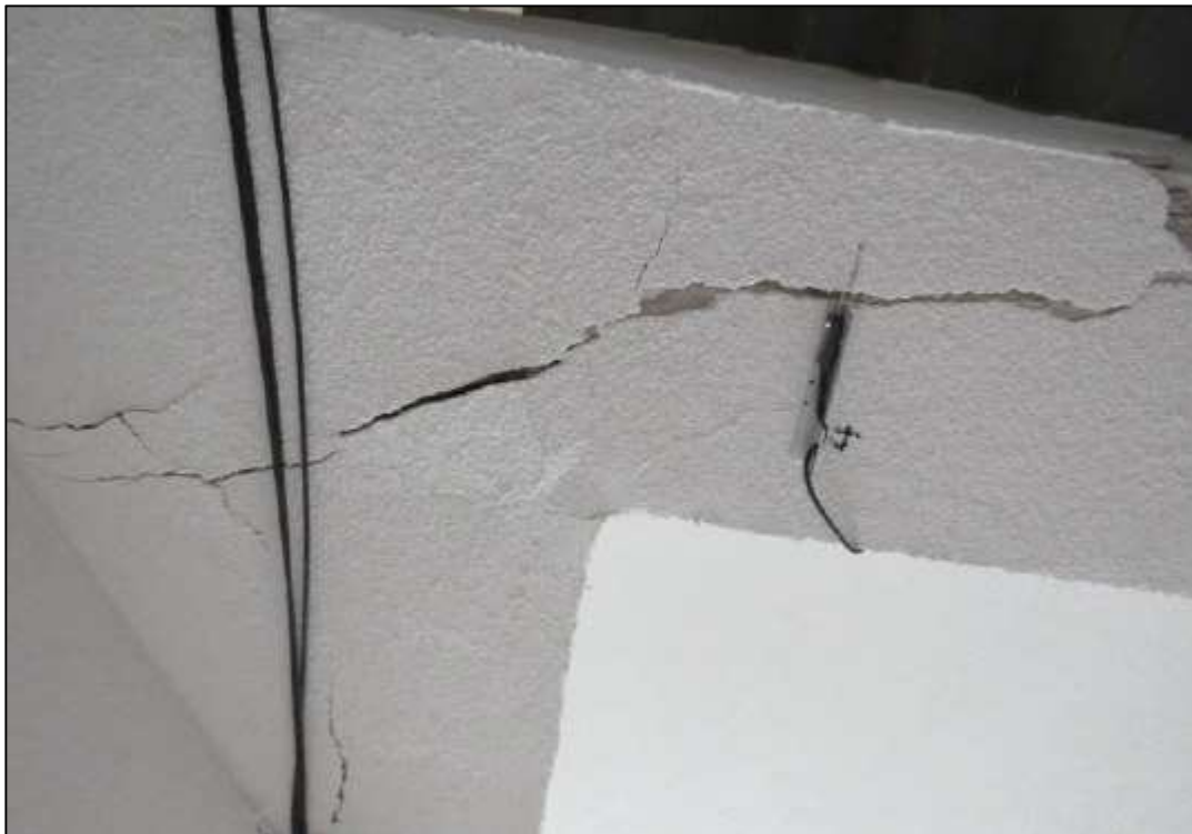
Bild 11: Rissensor Stiegenhaus
