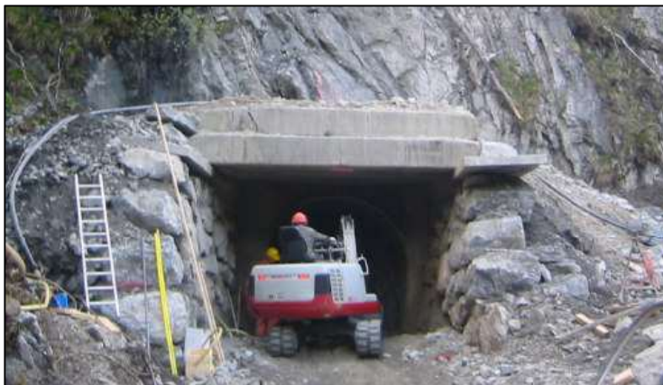
Abb. 13. Portal im Sommer 2004 (Stollenvortrieb).
