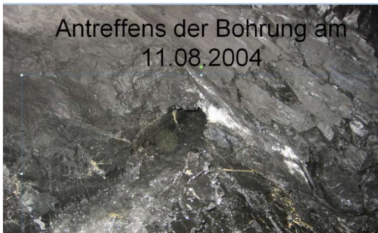
Abb. 10. Stollenortsbrust mit dem Bohrloch
