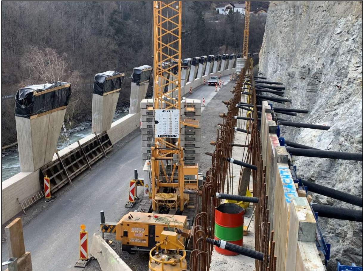
Bild 6 bergseitige Rückverankerung
