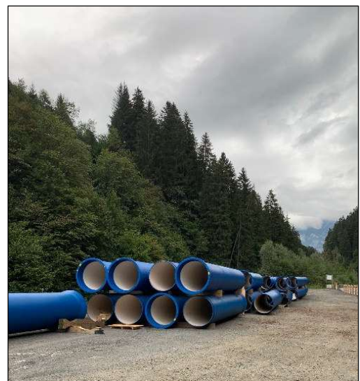
Abbildung 10: Rohrlager DN1000mm Guss
