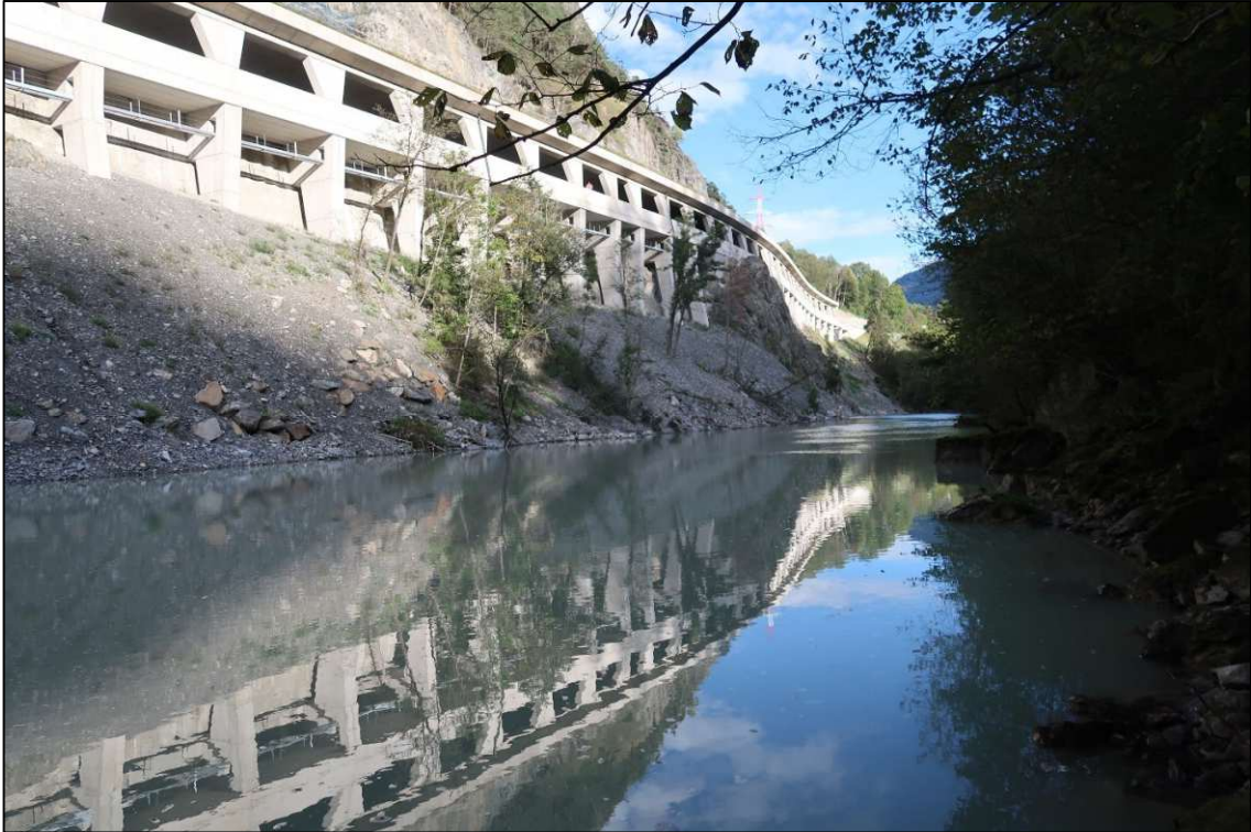
Abbildung 1: weitgehend fertiggestellte Galerie
