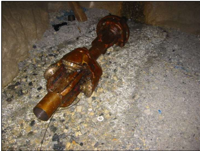
Abb.11. Im Stollen zurückgelassener Bohrkopf.
