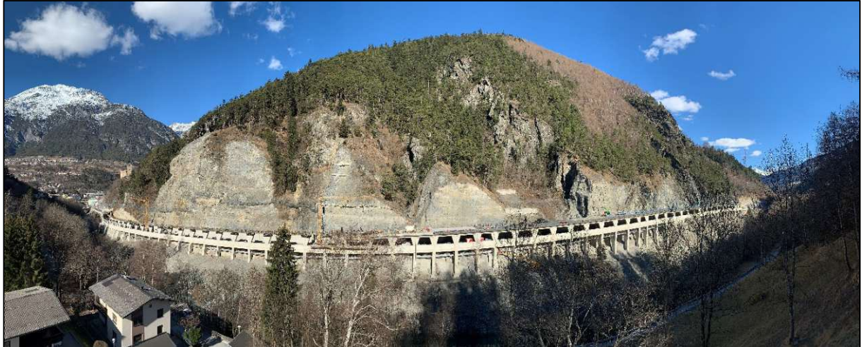
Bild 1 Übersicht der Baustelle
