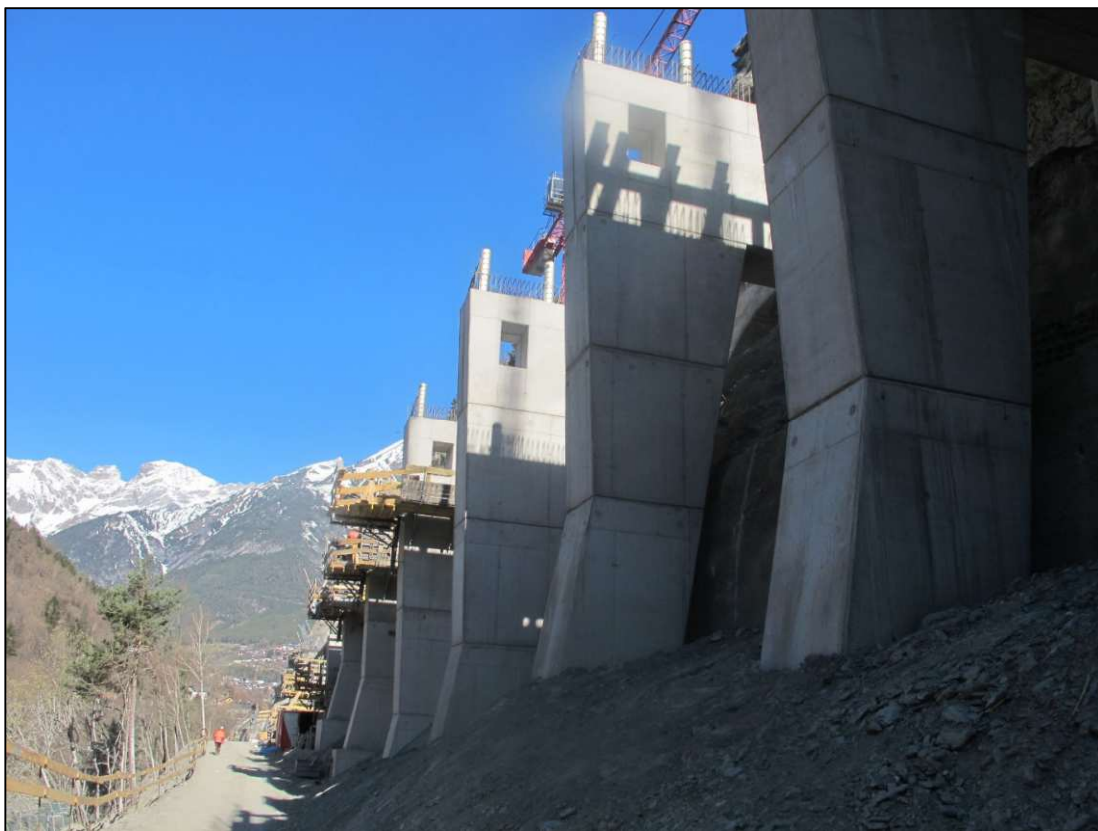
Abbildung 18: talseitige Pfeiler mit Höhe bis 30 m
