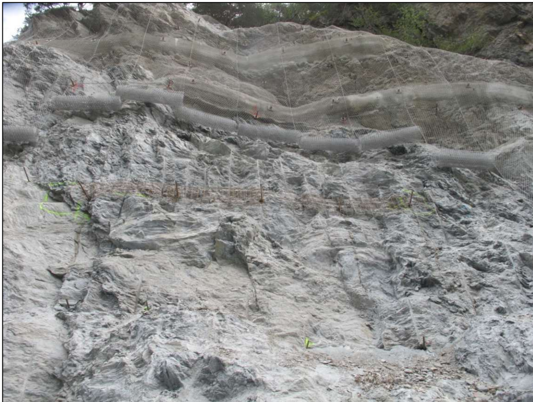
Abbildung 11: schrittweise Sicherung der Felsböschungen
