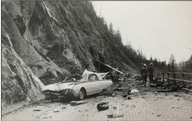
Abbildung 7 Felssturz 1966 auf der Gasteiner Straße - dieser Teil der Straße ist heute durch einen Tunnel ersetzt
