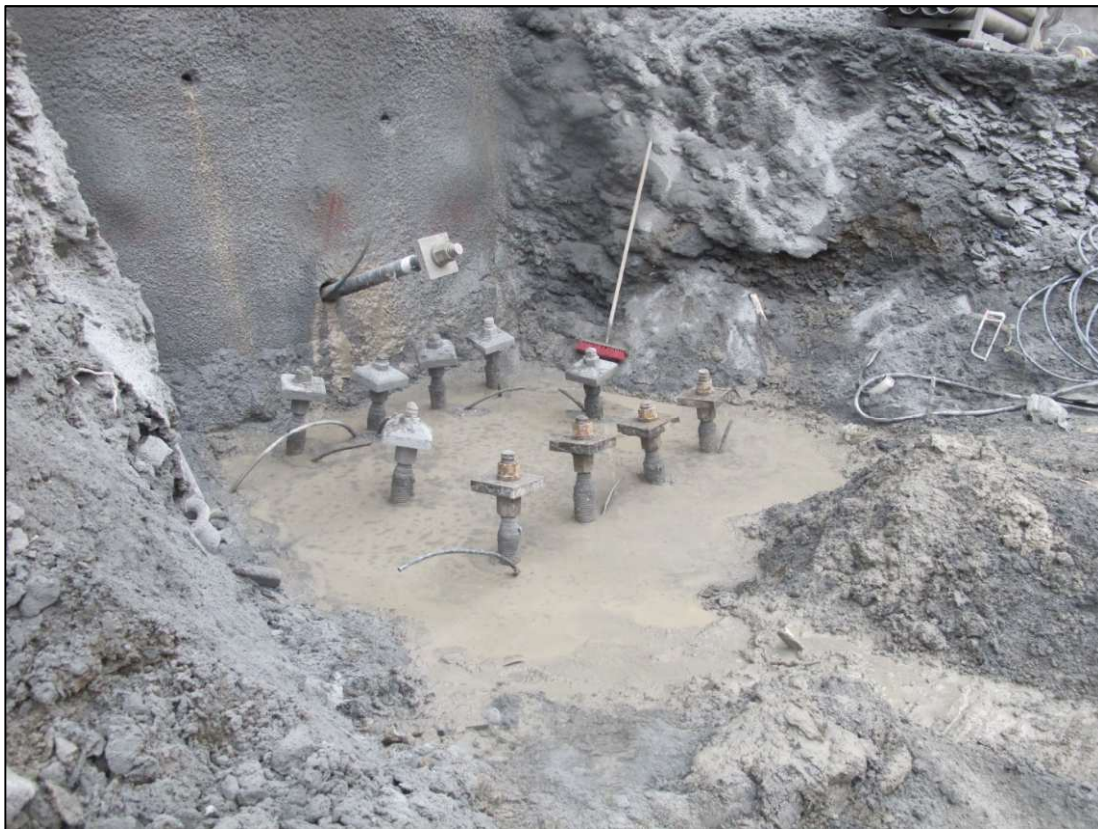
Abbildung 20: Pfeilergründung auf Pfählen
