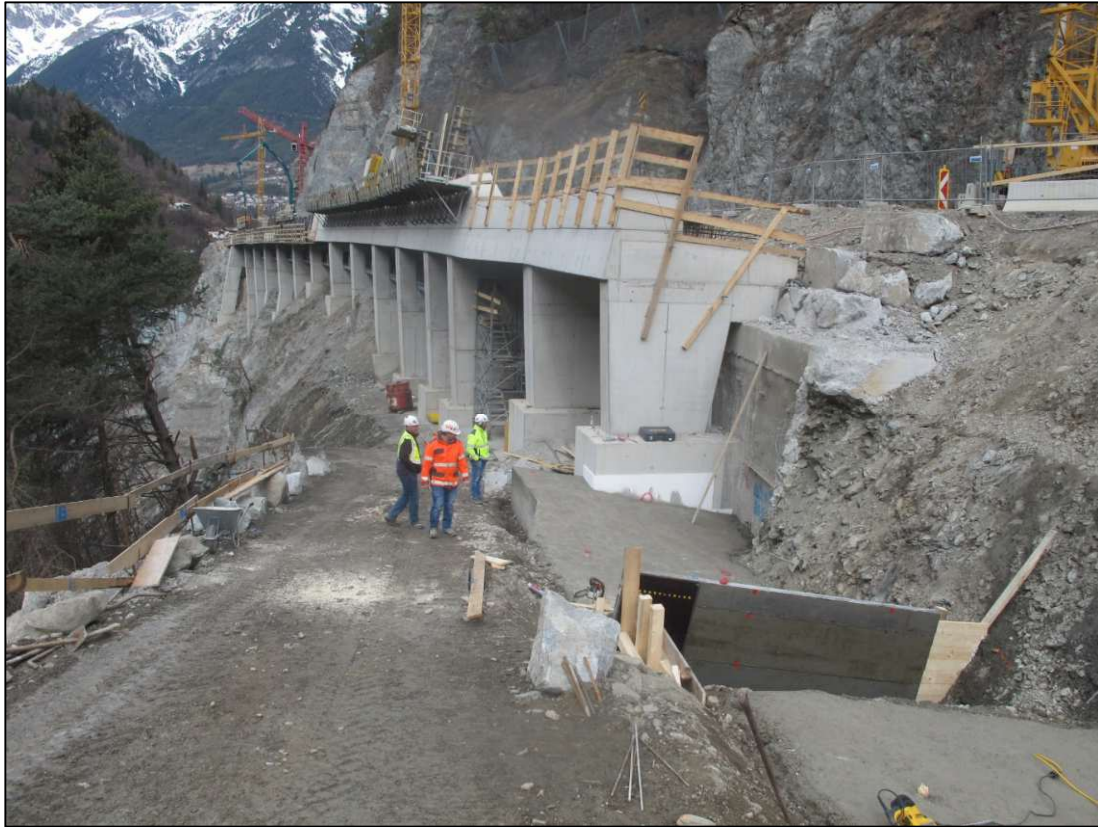
Abbildung 17: talseitige Pfeiler beim Südportal
