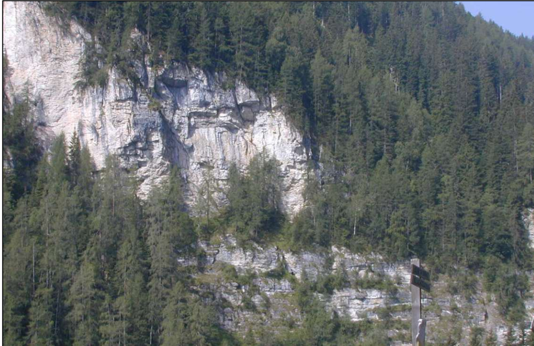
Abb.2. Wandstufe in der Abwasserkanaltrasse
