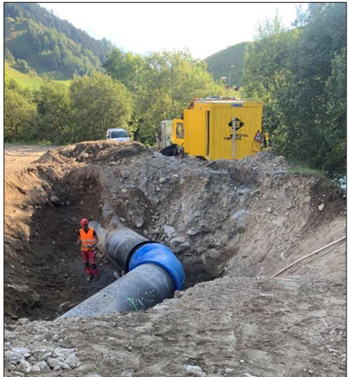
Abbildung 14: Aushubbereich, Bodenklasse 6
