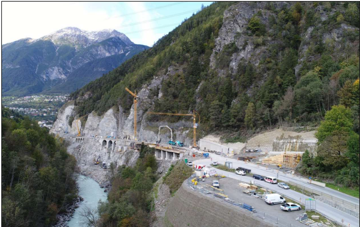
Abbildung 9: Baufeld mit Felsabtrag bei den einzelnen Pfeilern
