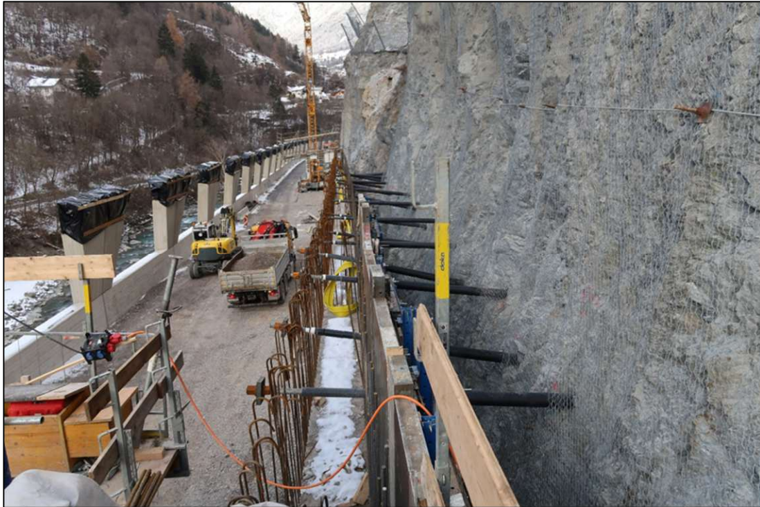
Abbildung 21: Verankerung der Galerie an der Bergseite
