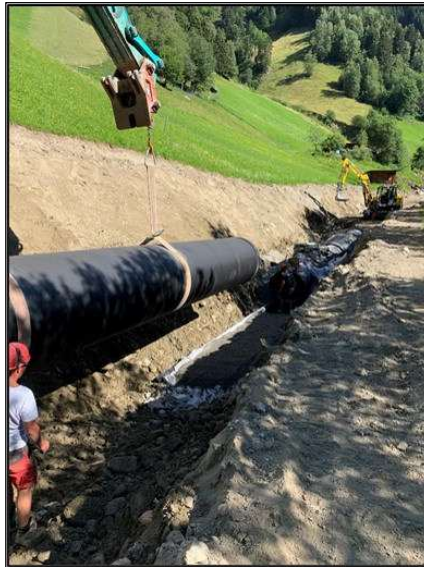
Abbildung 20: Verlegung Druckrohrleitung in Recycling-Bettungsmaterial
