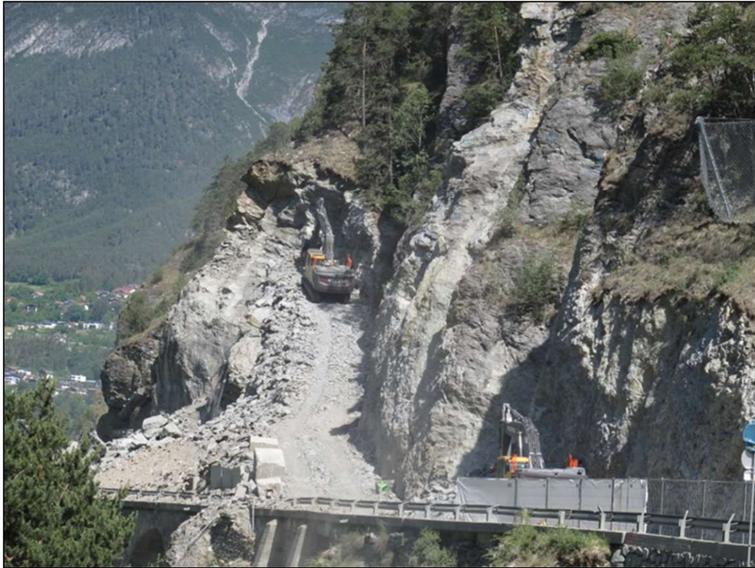
Abbildung 10: Felsabtrag mittels Bagger und Sprengung
