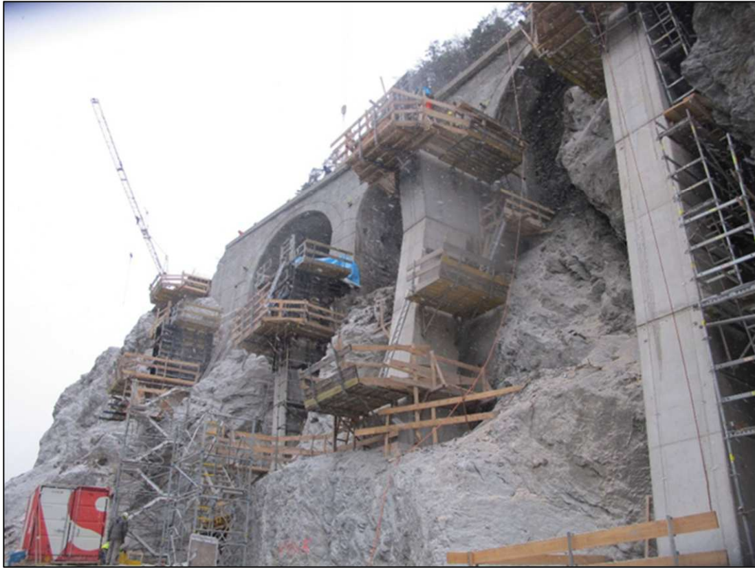
Abbildung 19: Gründung der Pfeiler im steilen Fels
