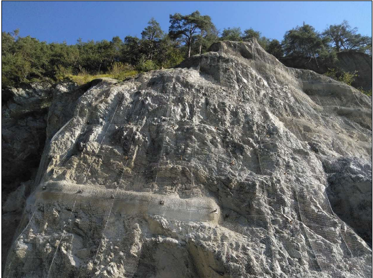
Bild 2 fertig gestellte, gesicherte Felsböschung
