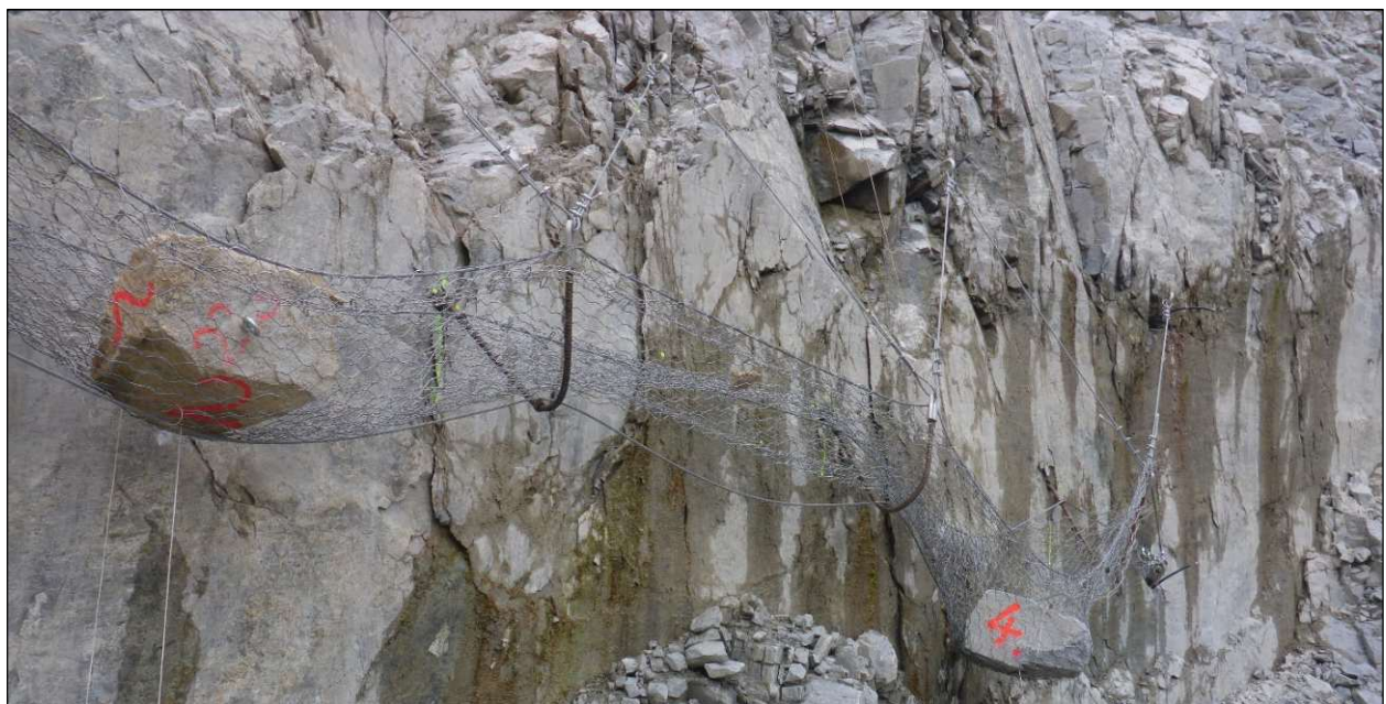
Abb. 5: Drahtzaun mit Pfeifer Slope Stabilization System (Geflechtsumschlag) nach Energieeintrag im Mittelfeld (Versuch 1: 60 kJ) und im Randfeld (Versuch 1.1: 70 kJ)
