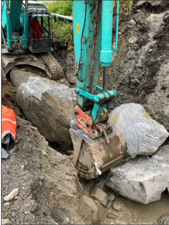
Abbildung 13: Aushubbereich, Bodenklasse 7
