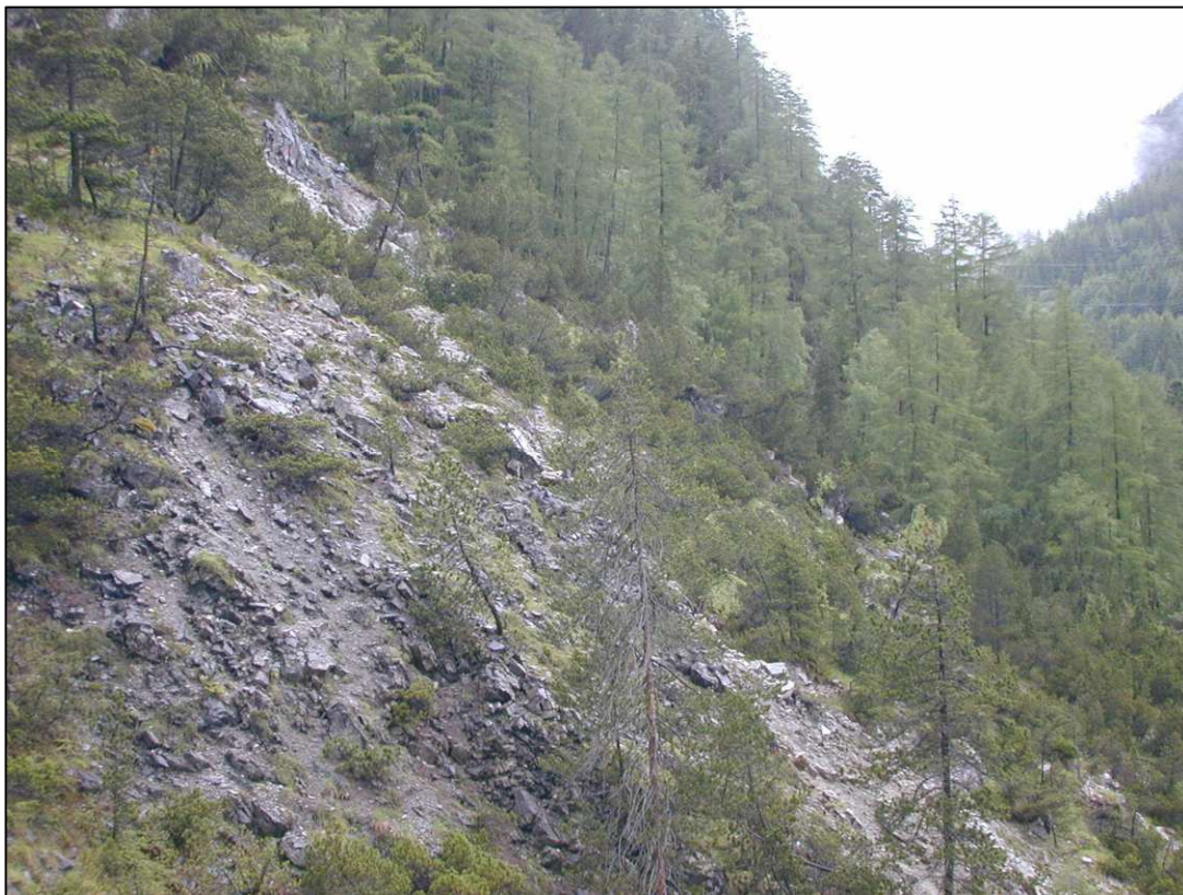
Abb.3. „Schutthalde“ im Trassenbereich
