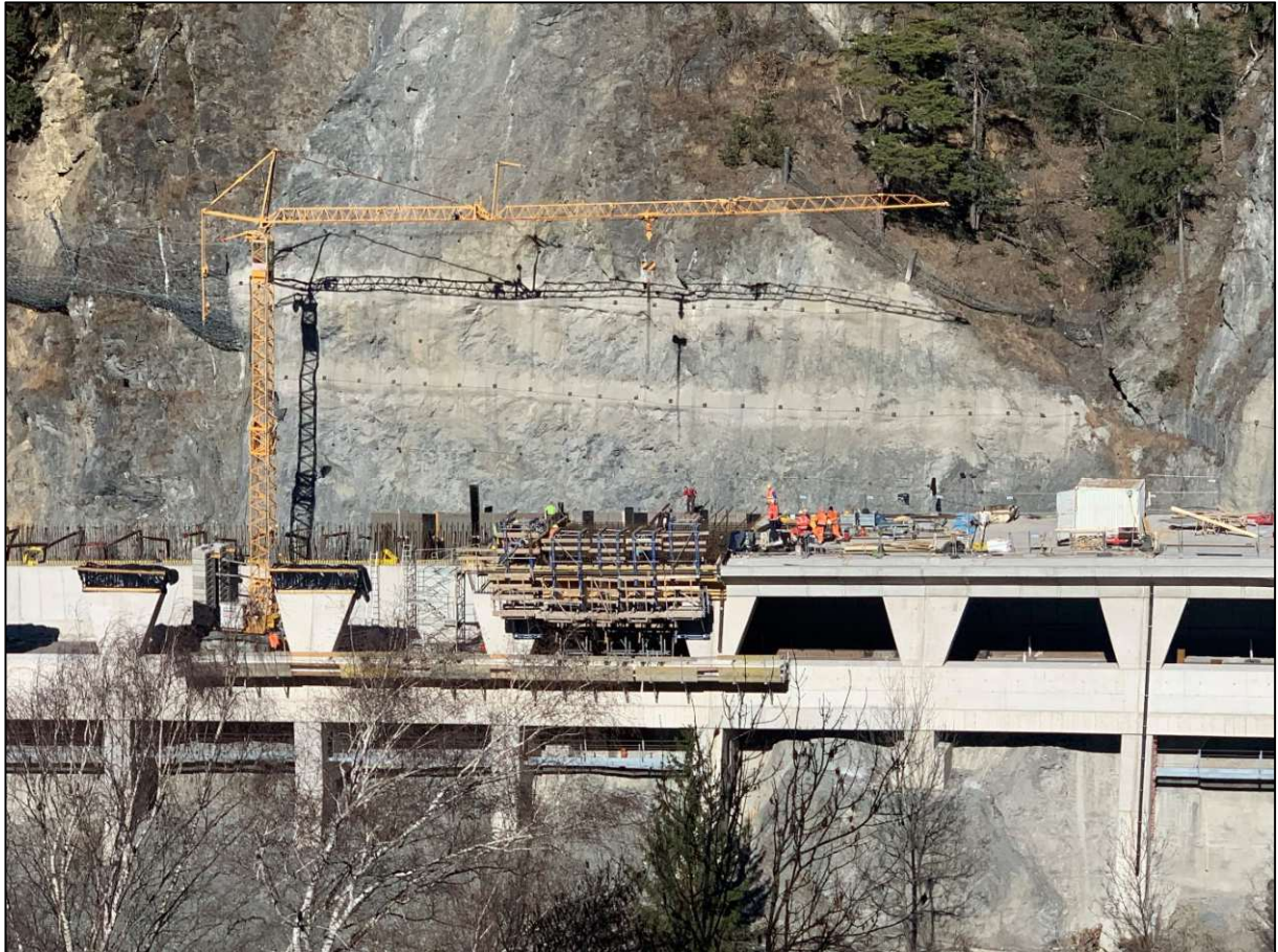
Bild 14 Taktbetrieb Tragwerksdecke
