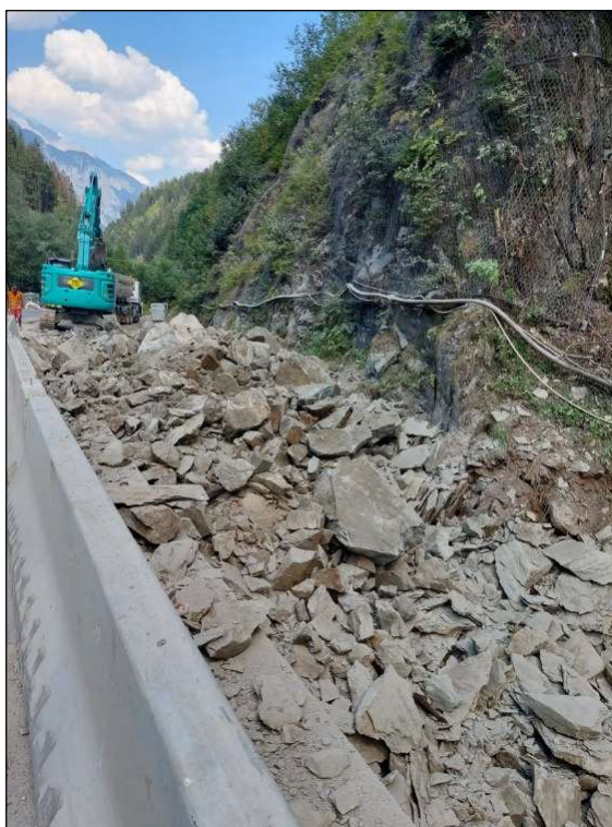
Abbildung 21: Ausbruchmaterial Rohrkünette Schluchtbereich
