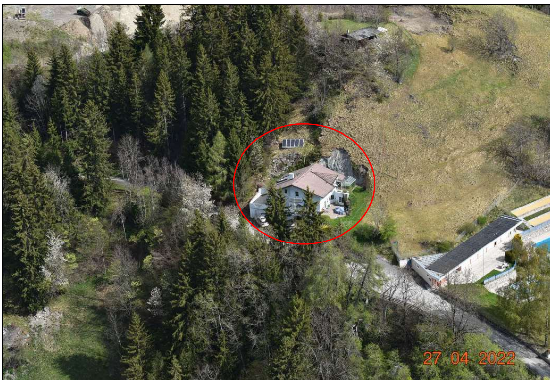
Bild 17: Betroffenes Gebäude von oben
