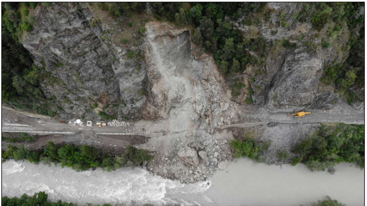
Abbildung 13: Abbruch eines Felsfeilers an einem Wochenende noch bevor die Sicherung oder der Abtrag festgelegt werden konnte, Ausbruch an weitgehend schieferungsparalleler Klufffläche
